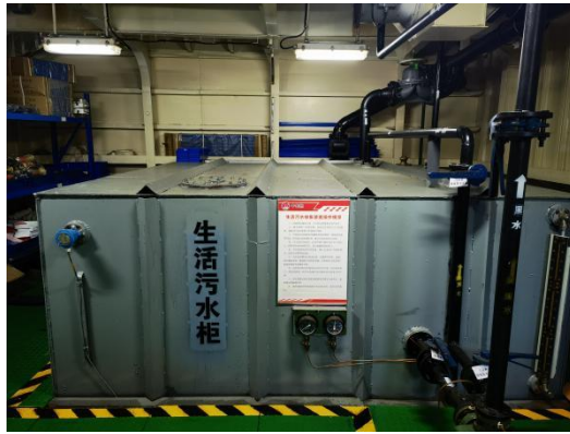
图 3 船用生活污水处理装置
